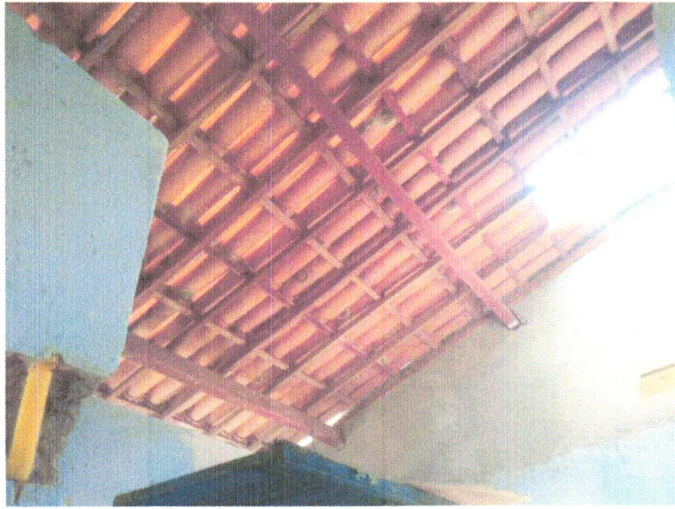
FOTO 13 - Retelhamento em cobertura com telha ceramica tipo canal comum, Itabaiana ou similar.
