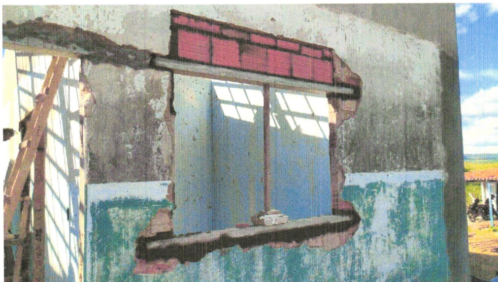
FOTO 12 - VERGA PRÉ-MOLDADA PARA JANELAS COM ATÉ 1,5 DE VÃO. AF_03/2016
