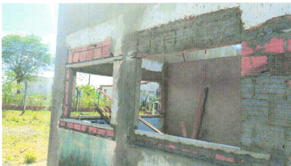
Foto 09– VERGA PRÉ-MOLDADA PARA JANELAS COM ATÉ 1,5 DE VÃO DE COMPRIMENTO. AF_03/2016
