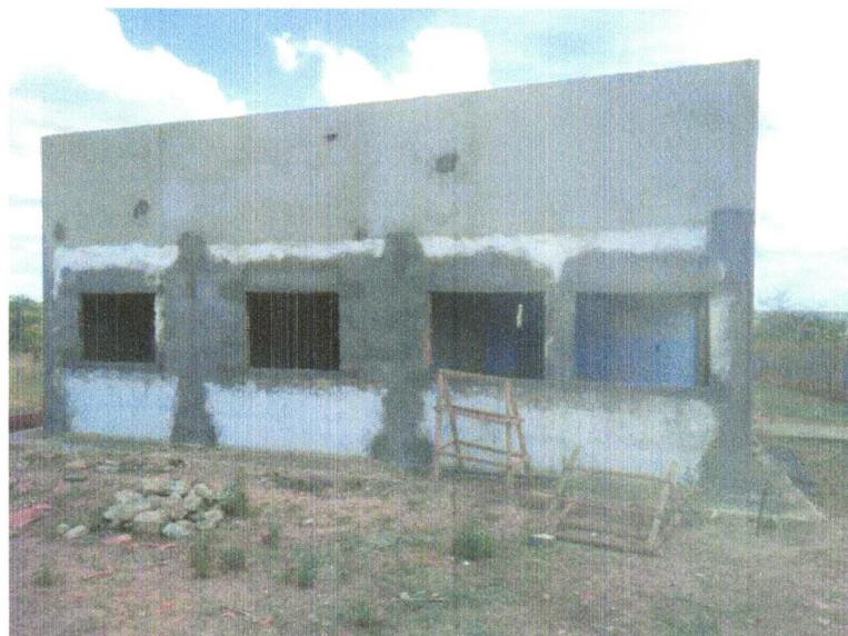
FOTO 16 - (COMPOSIÇÃO REPRESENTATIVA) EXECUÇÃO DE ESTRUTURAS DE CONCRETO ARMADO, PARA EDIFICAÇÃO HABITACIONAL UNIFAMILIAR TÉRREA (CASA EM EMPREENDIMENTOS) FCK=25MPA. AF_01_01/2017
