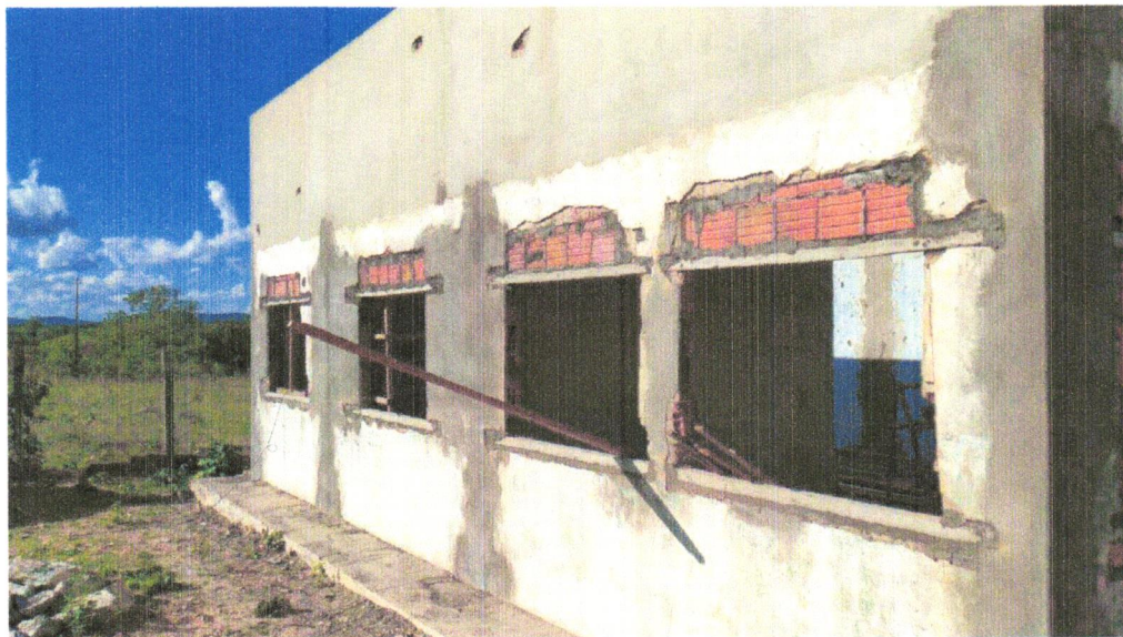
FOTO 11 - VERGA PRÉ-MOLDADA PARA JANELAS COM ATÉ 1,5 DE VÃO. AF_03/2016
