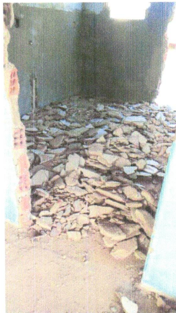
FOTO 04 - Demolição manual de piso cimentado sobre lastro de concreto - Rev 01
